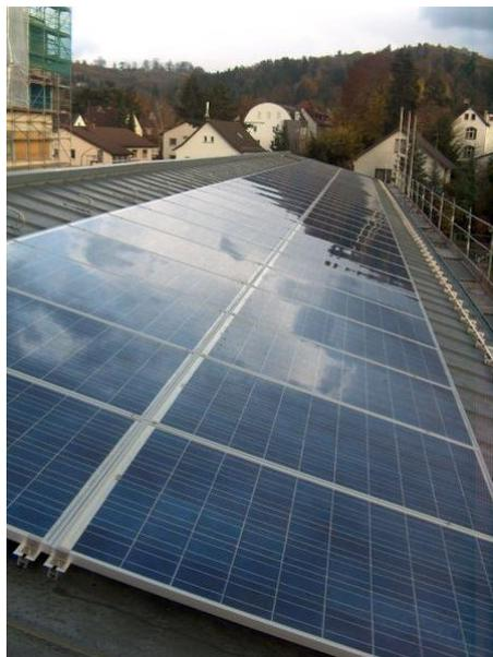
**Figura 5.10:** *Un impianto fotovoltaico di circa 5 kWp di potenza nominale*
